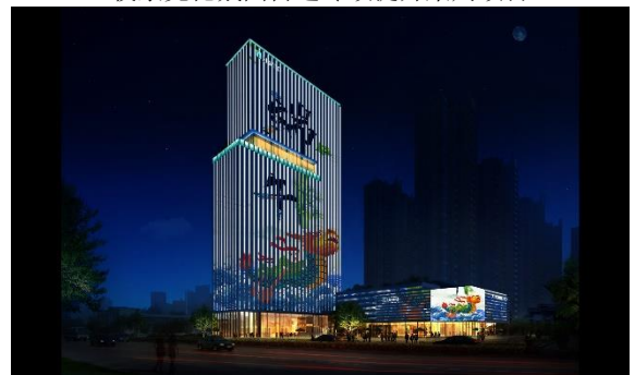
天都首郡二期地块项目 （黄山旅游大厦）泛光照明工程
