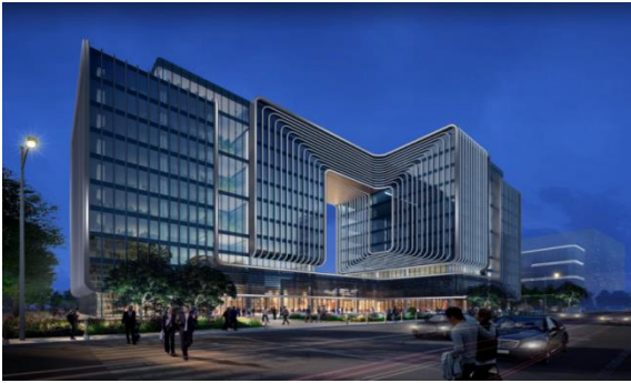
中国重燃研发总部基地项目夜景照明工程设计
