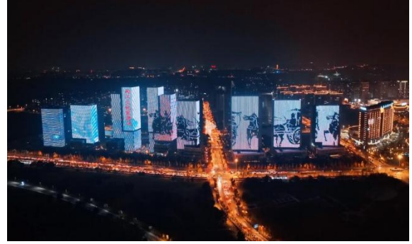
徐州金融集聚区延昆仑大道地块泛光照明工程
