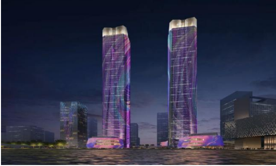
张江中区 58-01 地块项目泛光照明工程
