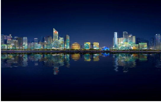
钱塘江北岸城市照明提升 (钱江新城段) 项目 EPC 总承包工程
