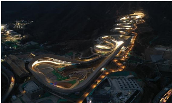
国家雪车雪橇中心赛道照明专业工程一标段
