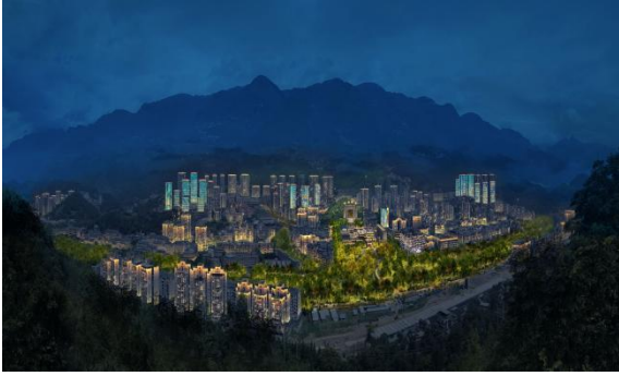
巫溪县城市绿色照明升级改造及基础设施 改造工程 EPC 总承包
