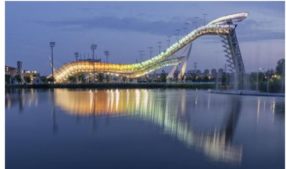
首钢滑雪大跳台中心项目
